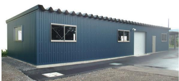
▲ 片流れタイプ 妻面6m×桁行き18m
