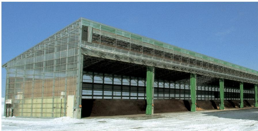
△ 片流れタイプ 妻面12.6m×桁行き99m
