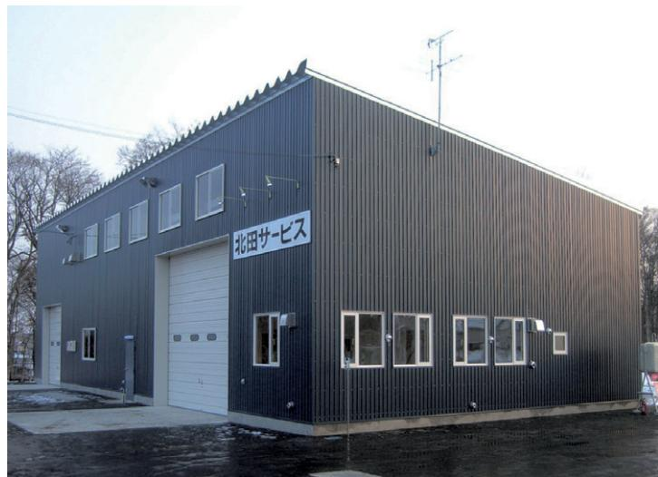
△ 片流れタイプ 妻面12m×桁行き26.3m
